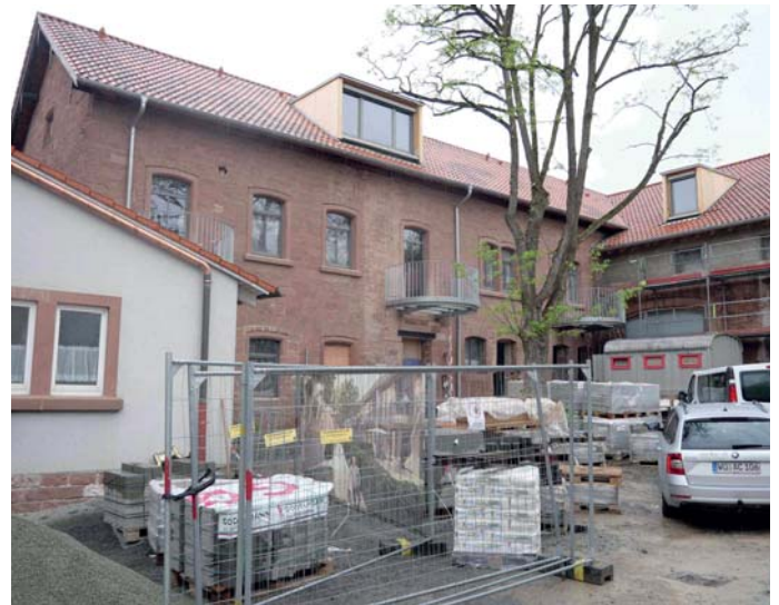
Gelungene Innenentwicklung: Die „Alte Schule“ in Uettingen soll künftig modernen Wohnraum für alle Generationen bieten. Auf dem Areal sollen außerdem kleine Läden und eine Hausarztpraxis Platz finden.
